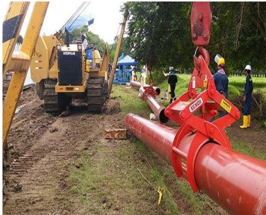
Fig. 5. Scissor Grab Pipe Lifter
